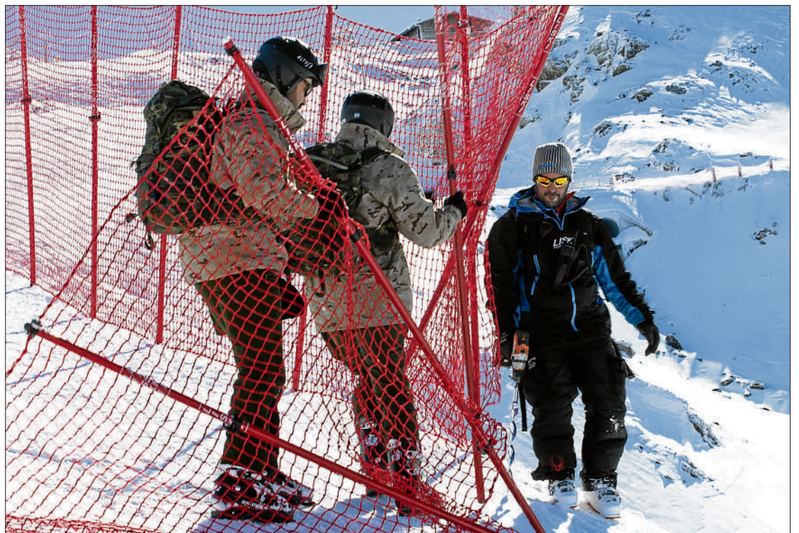
Militares colaboran en la construcción de las pistas. / Some soldiers building the tracks.
